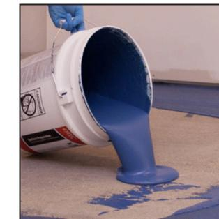
**APPLIQUER LA PREMIÈRE COUCHE** sur le support à raison de 400 g/m<sup>2</sup> avec une taloche/spatule à lame interchangeable 28 cm : A3.
